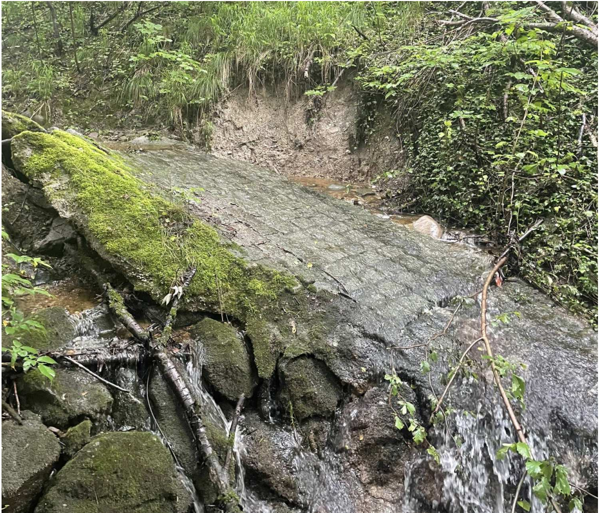
Abbildung 3: Ehemaliges Rückhaltebecken im Kühbach
