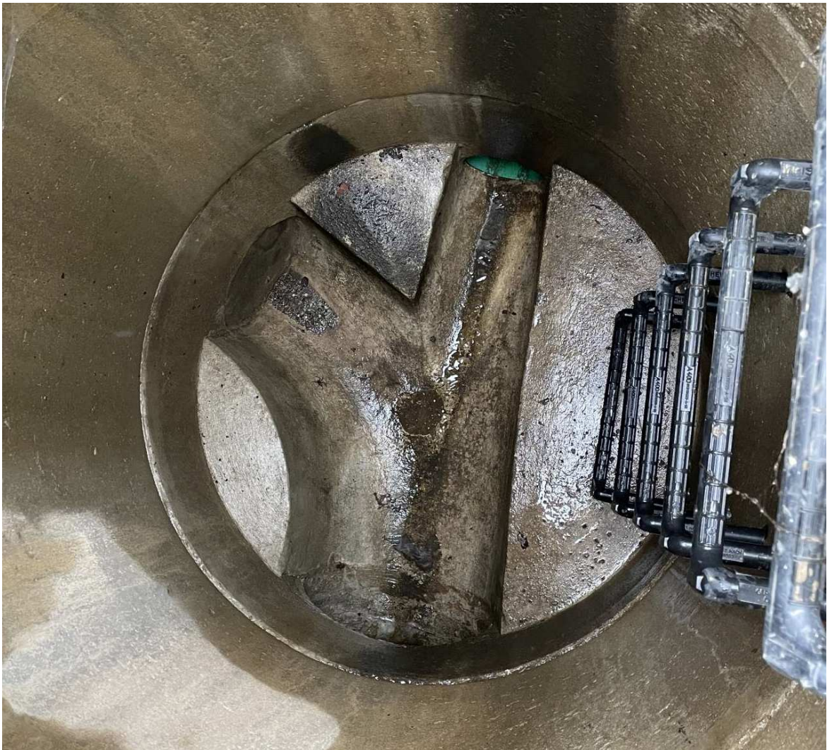
Abbildung 2: Schacht R1156.11 mit verschlossenem Zulauf von Norden (Blick nach Osten)
